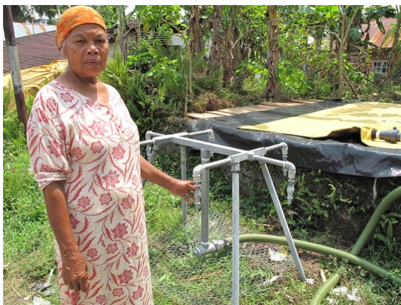
スンガイ・リマウ地域のスンガイ・シラ村でCWSが設置した 簡易水道の蛇口からきれいな水を汲むマリアナさん
